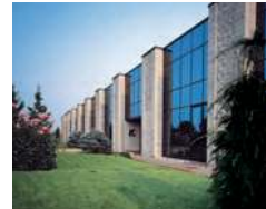
Usine de Pavie : IT Cooling
