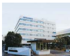
Usine de Shizuoka au Japon
