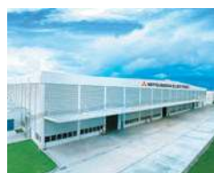
Usine de Chonburi en Thaïlande
